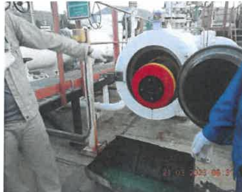
รูปที่ 2-16 การส่ง Cleaning Pig
