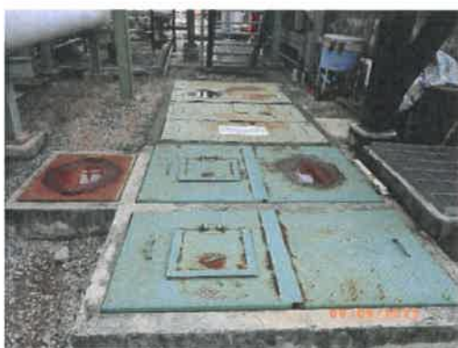
ระบบ OWS ส่วนแยกน้ำมันและส่วนน้ำใส บริเวณสถานีสูบน้ำจ่ายน้ำมันมาบตาพุด
